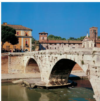
K02_025 CD-Rom: 03 Italien • Rom • Ponte Cestio
